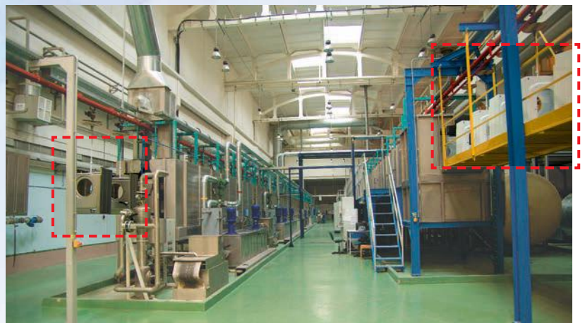
Beispiel einer Lackierstraße für Waschmaschinegehäuse. Links das Bauteil vor dem Lackieren, Rechts der Auslauf der lackierten Gehäuse.
